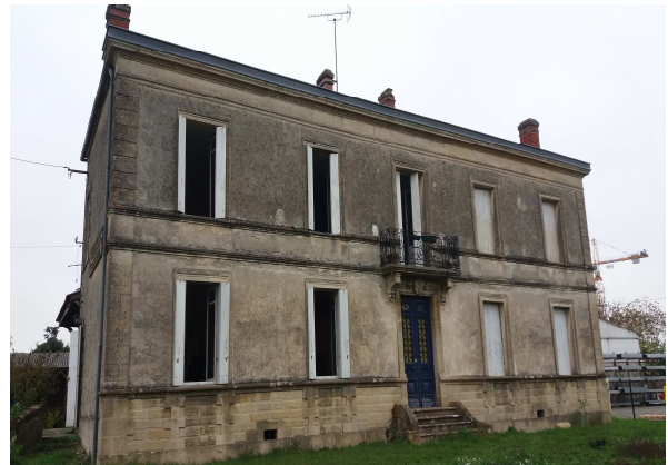
Maison (avant travaux) qui accueillera l'Antenne Locale de l'ADAV33 en Sud-Gironde à compter du 2 ème semestre 2019
